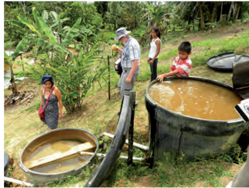
Det bruna flodvattnet fylls på i den övre filtertunnan.
