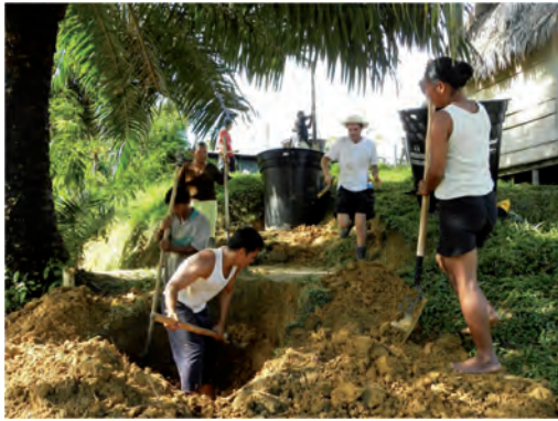
Arbete för att få reningsverket på plats.
